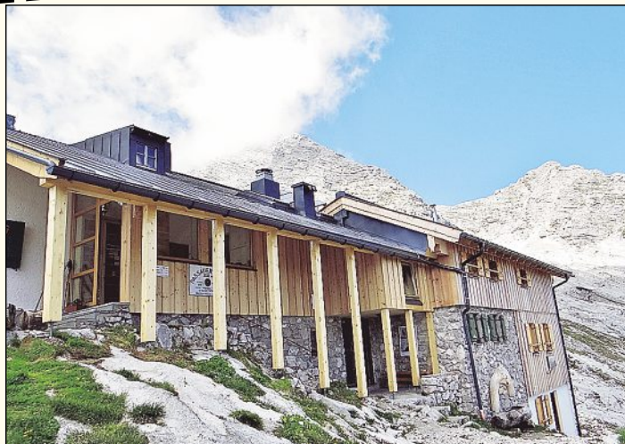
Nach der Sanierung erstrahlt die Hütte in neuem Glanz
